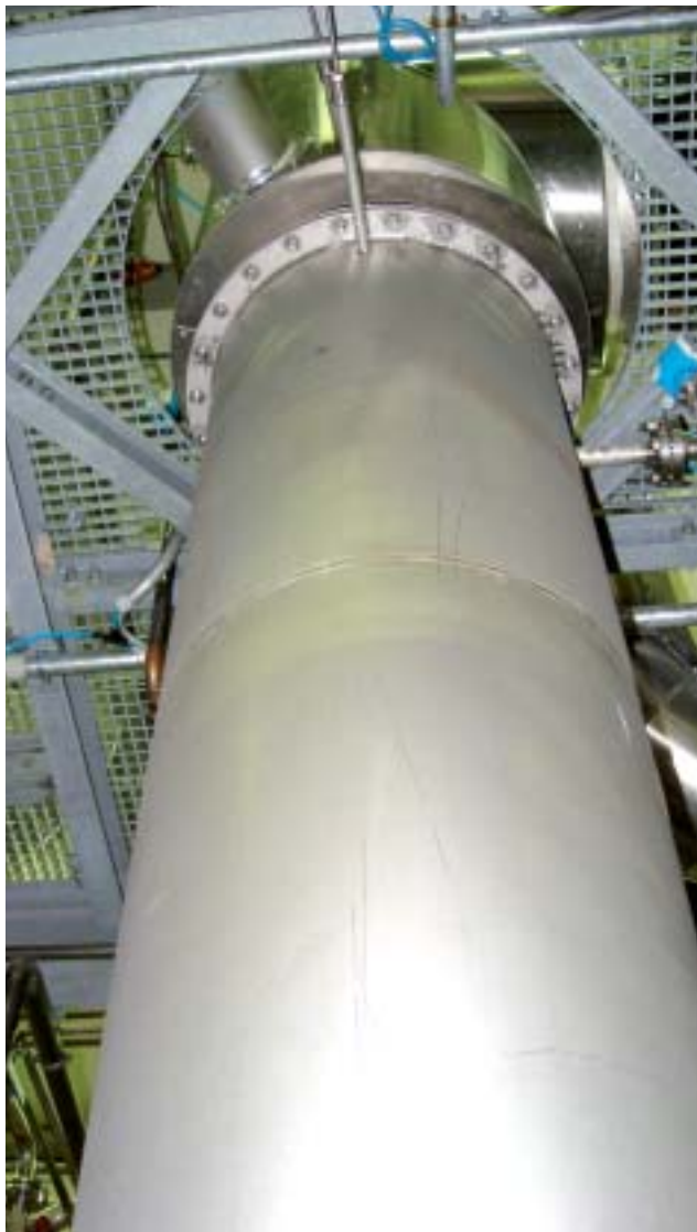
Hochtemperaturheißgas-Quenche für die Abgase aus einer Anlage für thermische Nachverbrennung
