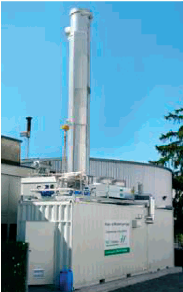
weltweit erste drucklose Biomethananlage mit Einspeisung in das Erdgasnetz unter 100 mbar und ohne Brennwertanpassung und ohne Methanverluste im Juni 2008 in Meilen (CH)
