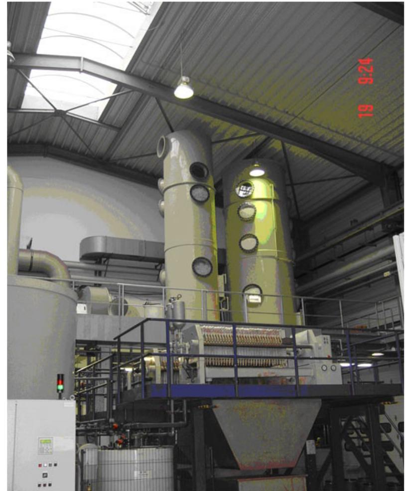
NOx-Waschkolonnen für langsam auflaufende Chemosorption mit Abgasvolumen von 1.000 Nm<sup>3</sup>/h
